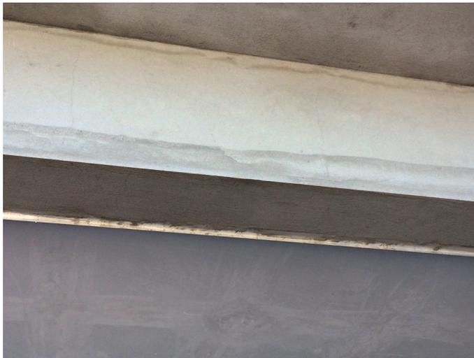
A situação é uma viga com fissuras verticais na sua face lateral. Sobre esta viga está apoiada uma laje treliçada. Os trilhos desta laje “começam” em outra viga, se apoiam nesta viga fissurada e tem um trecho de 80 cm em balanço.
