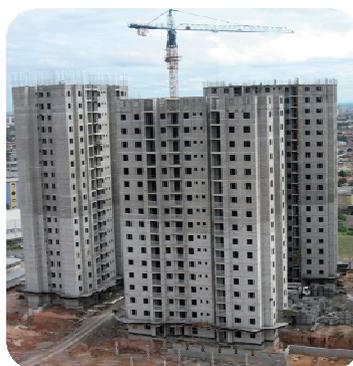
ESTRUTURA CONVENCIONAL EM CONCRETO ARMADO
