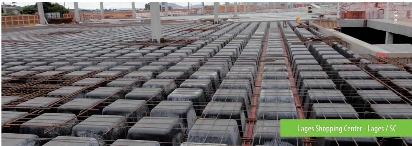
**FÔRMAS CIENTIFICAMENTE PROJETADAS PARA EVITAR DEFORMAÇÕES DURANTE A CONCRETAGEM**
