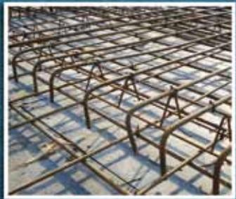
Espaçador Treliçado para apoio de ferragem negativa em lajes
