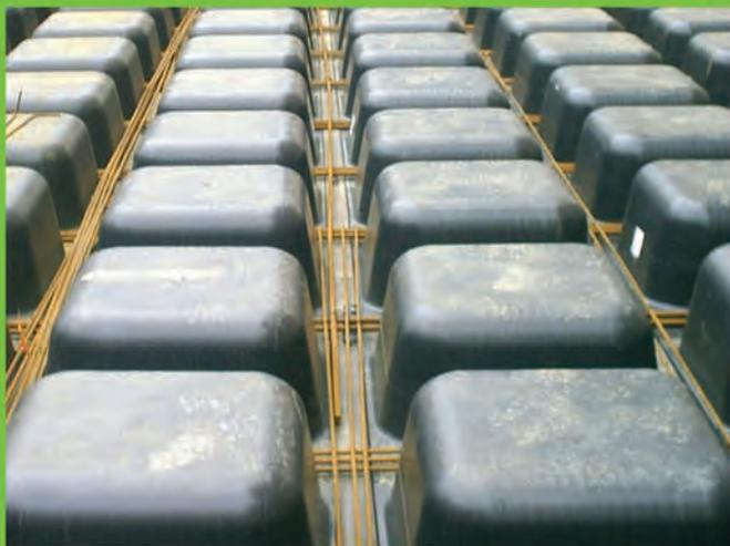
**Fôrmas cientificamente projetadas para evitar deformações durante a concretagem.**
