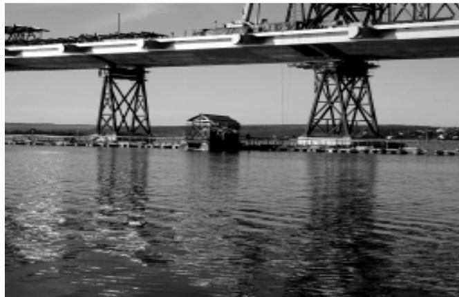
Pilar de sustentação "provisório" do tabuleiro da ponte
