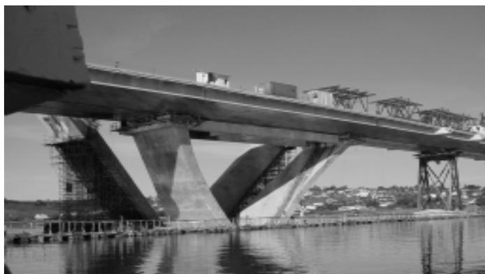
Pilares inclinados de apoio ao tabuleiro na parte "anterior" ao arco
