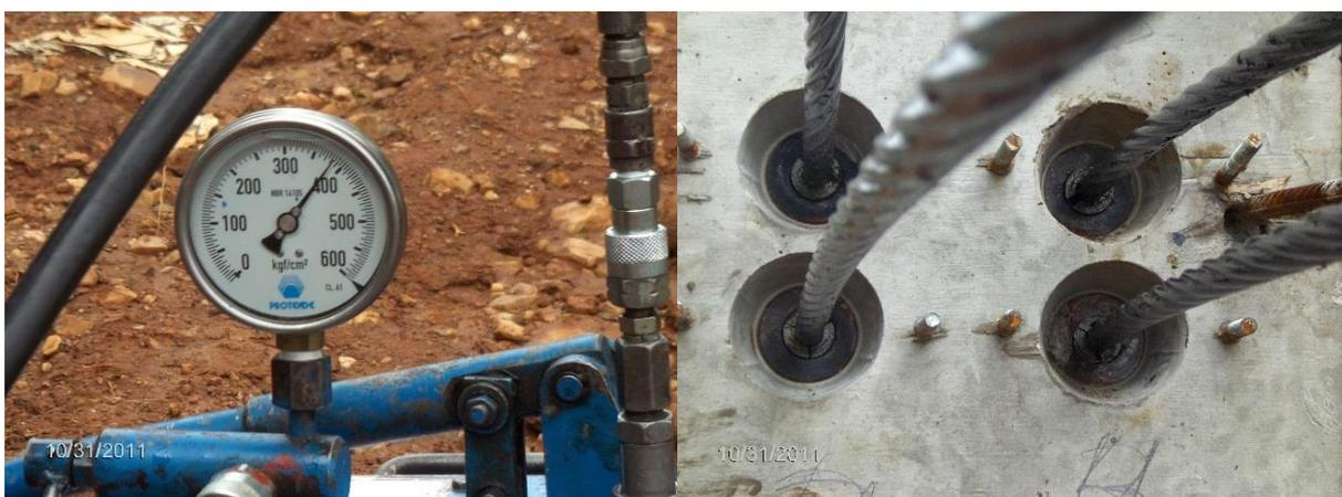
Figura 14.3 – Cordoalhas e protensão das vigas.
