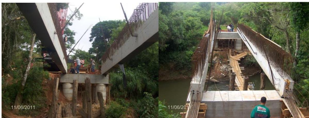
Figura 14.7 – Vigas lançadas já em posição.
