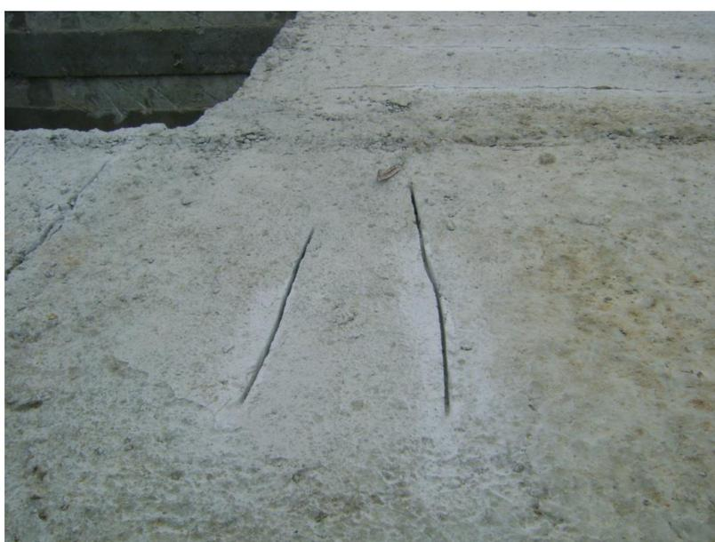
Figura 32.4 – Preparo das trincas para aplicação do selante.
