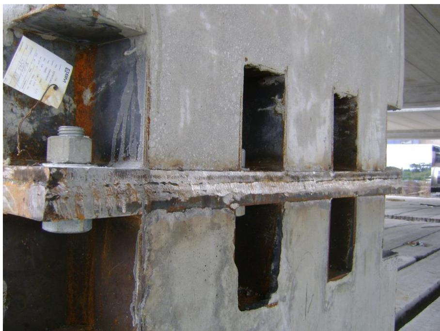
Figura 31.2 – Vista da solda aplicada na emenda das chapas entre as peças do pilar
