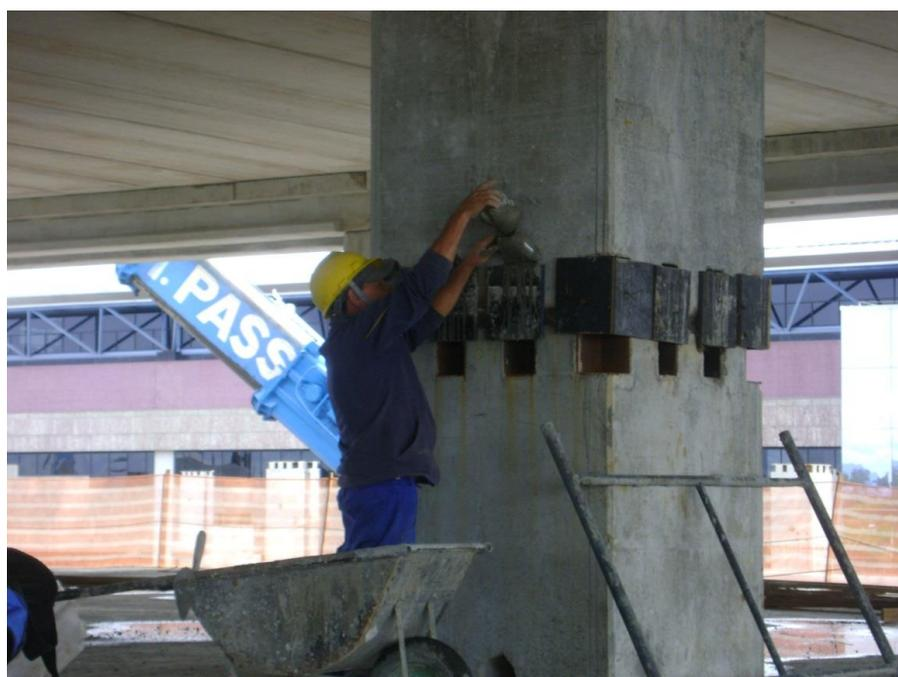
Figura 31.3 – Aplicação do graute de enchimento dos nichos dos parafusos
