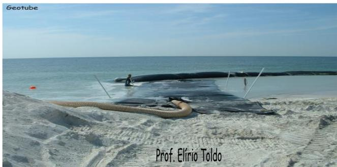
**2.6-Geomembranas alongadas cheias de micro concreto - Geotube**
