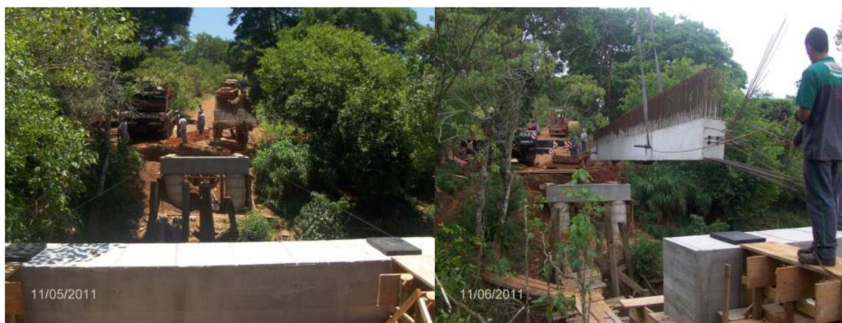
Figura 14.6 – Lançamento das vigas.
