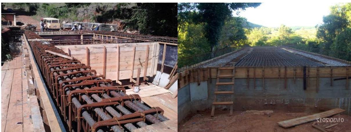
Figura 14.8 – Complemento das vigas e tabuleiro.
