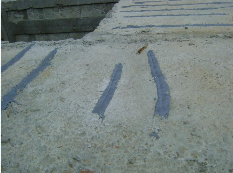
Figura 32.5 – Vista após aplicação do selante nas trincas.
