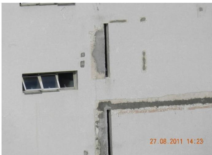
Foto 23.2 – Reparos efetuados em vigas e pilares da fachada acima.
